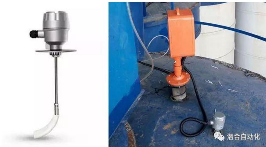
图3 阻旋开关仓顶安装图
