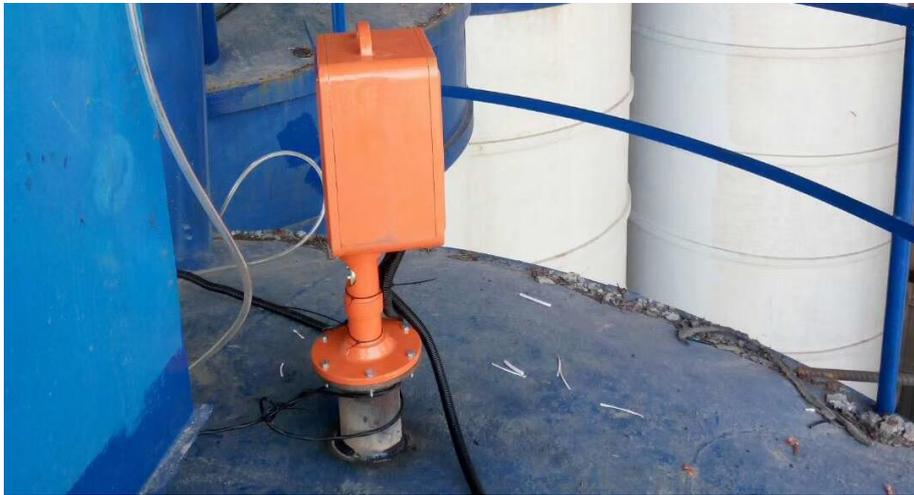
图 2 料位计仓顶安装图
